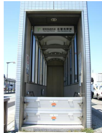
駅出入口の止水板
