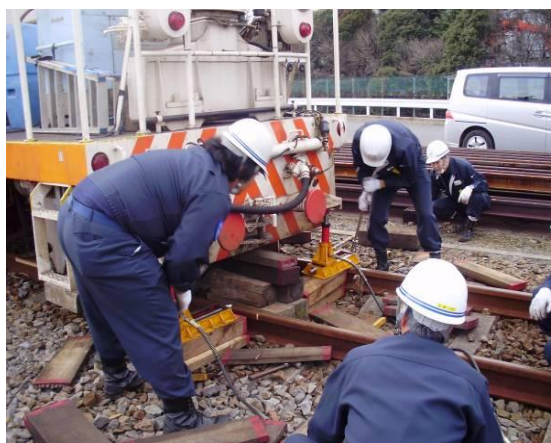
モーターカーをジャッキアップしている様子
