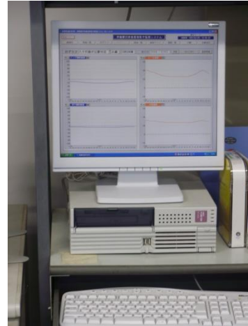
レール温度・雨量監視システム
