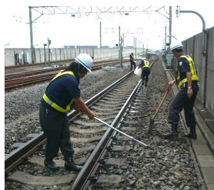
レールへの散水
