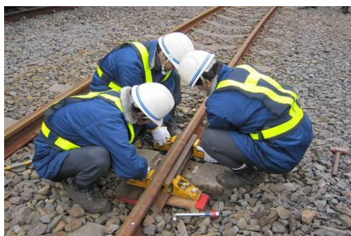
折損部に応急処置器を施している様子
