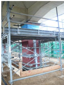
橋脚補強工事の様子
