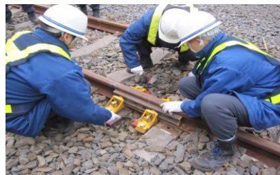
レール折損応急処置訓練
