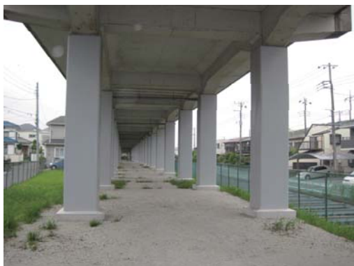
【高架橋柱の耐震補強（施工後）】
