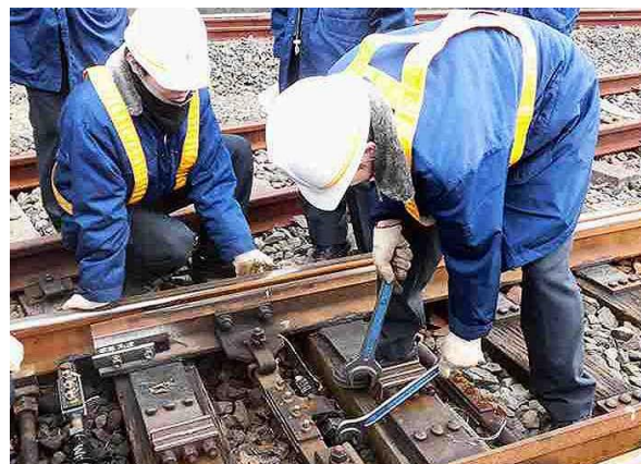
分岐器の点検
