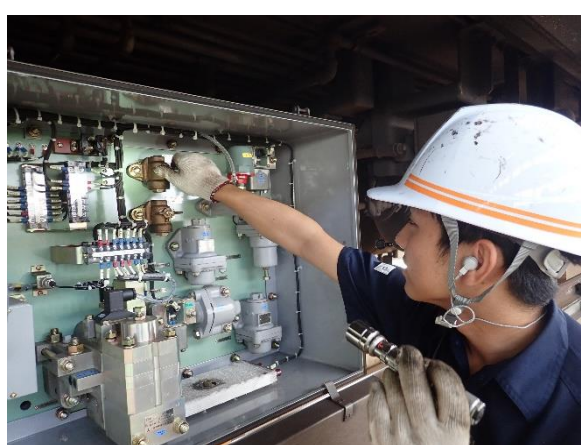
床下機器内の点検
