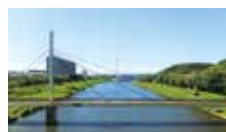
現在の新川。新川大橋から大和田機場方面をのぞむ。
